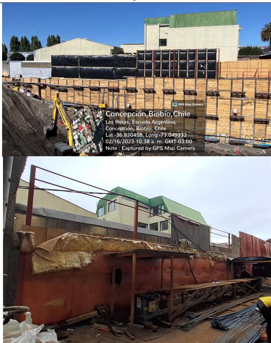
Figura 2. Registro fotográfico con la instalación de las barreras acústicas de la obra con fecha 16.02.2023 y 16.04.2024.
