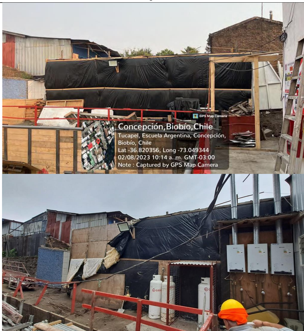
Figura 3. Registro fotográfico con la instalación de las barreras acústicas de la obra con fecha 16.02.2023 y 16.04.2024.
