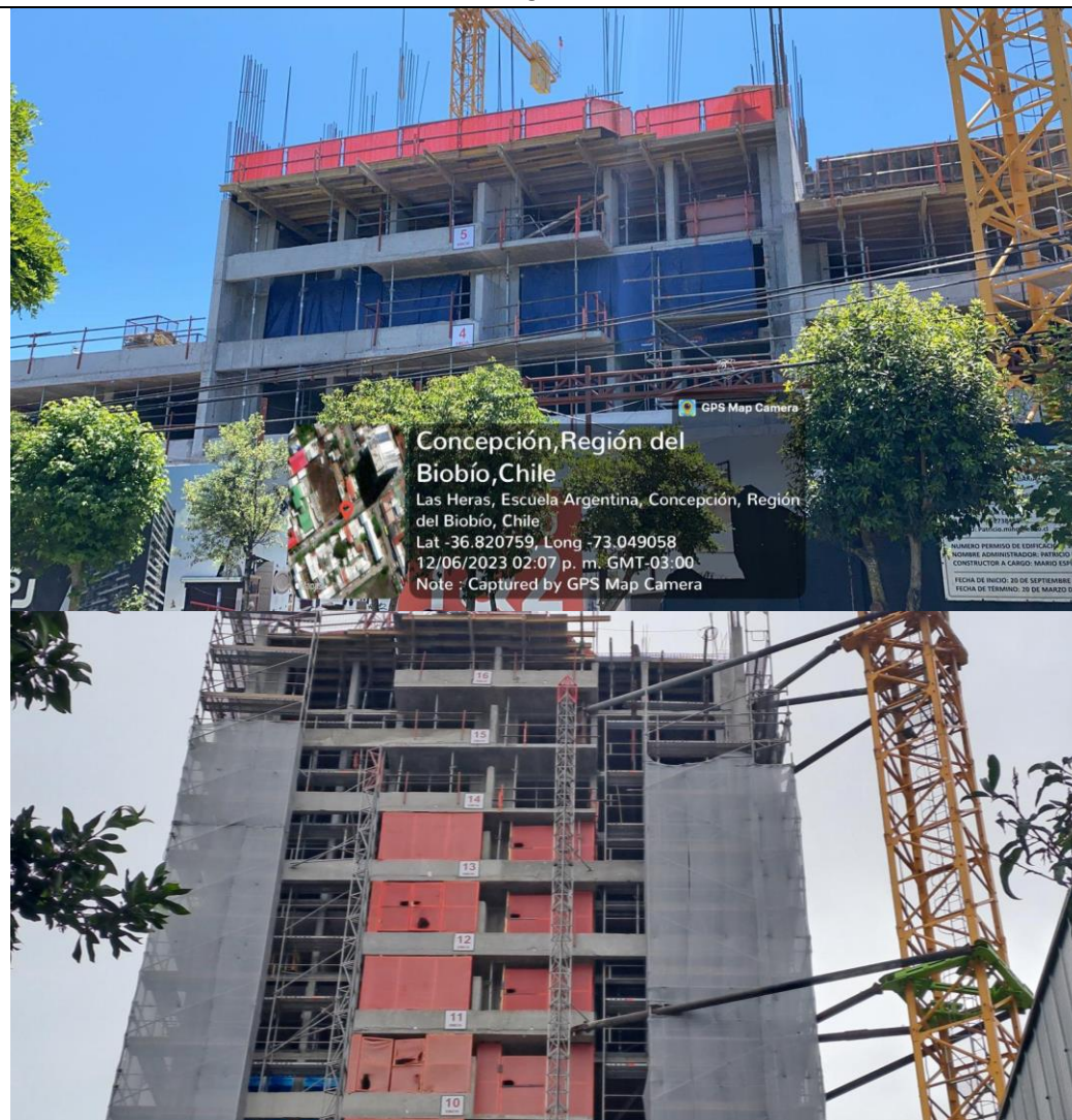
Figura 5. Registro fotográfico con la instalación de las barreras acústicas flexibles de la obra de fecha 12.06.2023 y de la obra durante la inspección de fecha 16.04.2024 sin las barreras flexibles instaladas.
