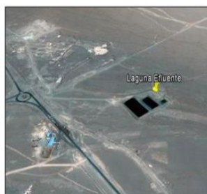
Figura N° 2: Ubicación Planta de Tratamiento de Aguas Servidas, Sector Planta (Punto Laguna Efluente).
