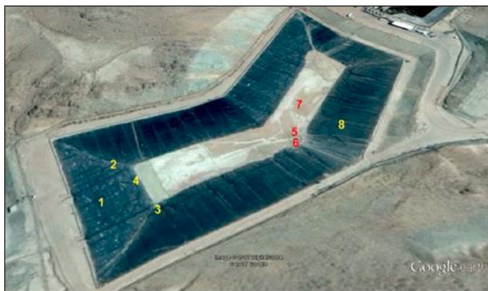
Imagen N°2. Zona de hallazgos y reparaciones en piscina emergencia ROM 1.
