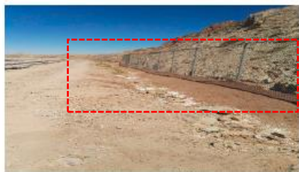
Retiro de material sobre malla
