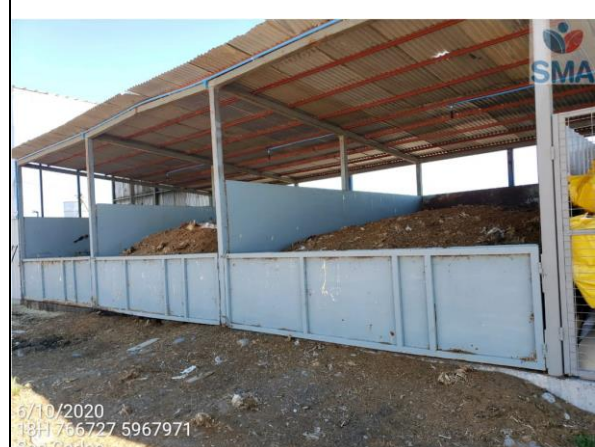
Foto 4: Sala de compostaje de mortalidad.
