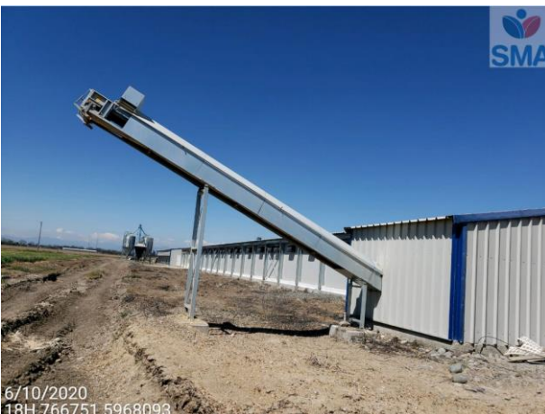
Foto 3: Exterior pabellón de Postura
