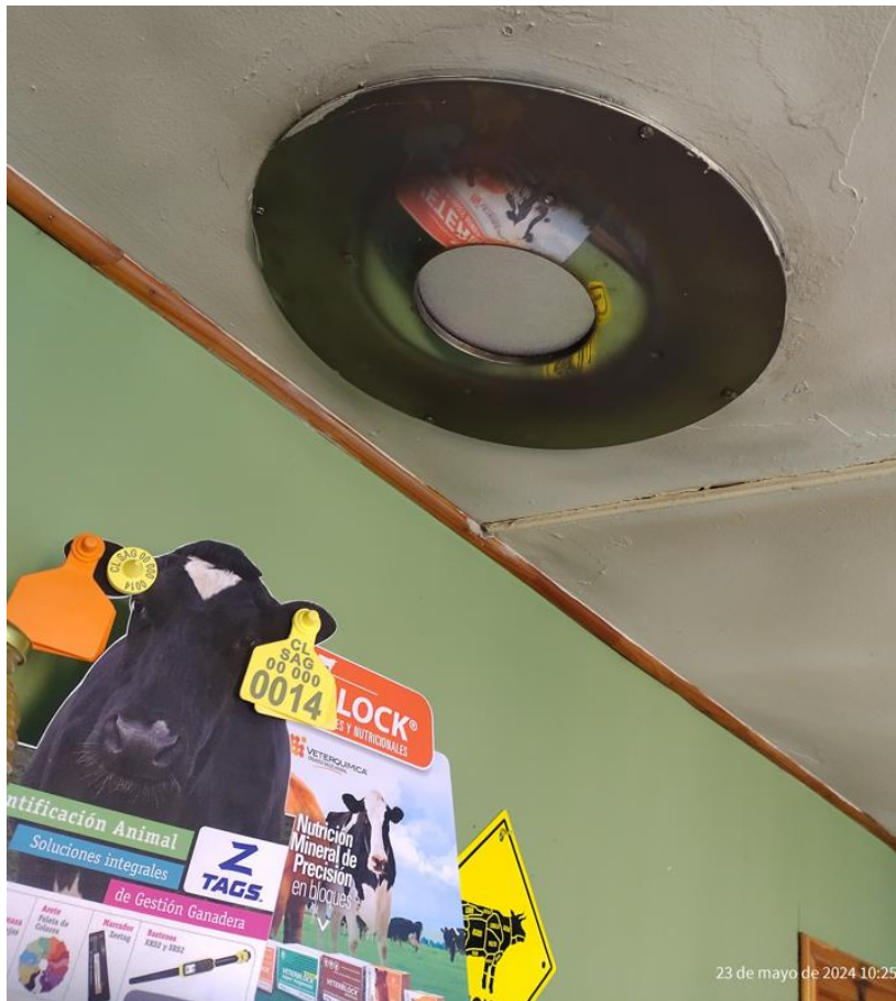
Fotografía N°3 Fecha: 23-05-2024 Descripción: Fotografía muestra el cielo raso de la Veterinaria, se retiraron los ductos del calefactor a leña, solo quedo instalada la roseta.
