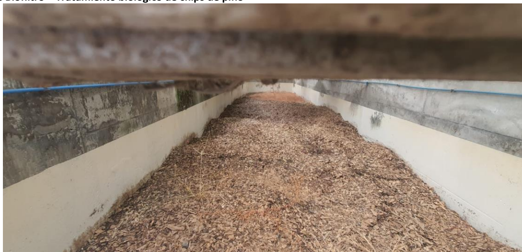
Foto 8 Sistema de Biofiltro – Tratamiento biológico de chips de pino
