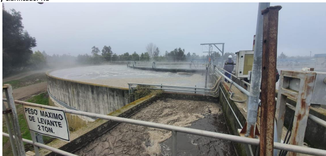
Foto 10 Reactor y Clarificador N1
