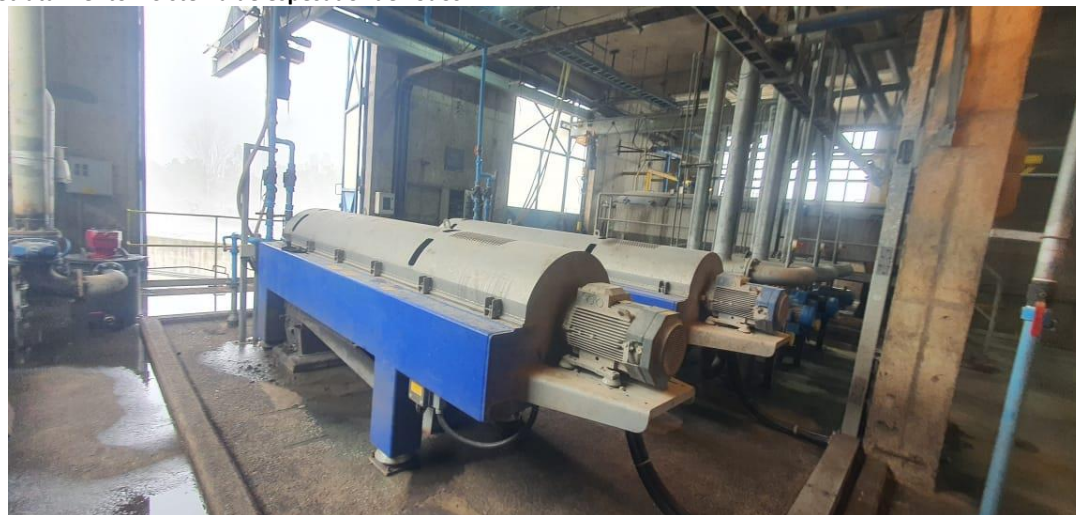
Foto 4 Edificio Pretratamiento – Sistema de espesador de Lodos
