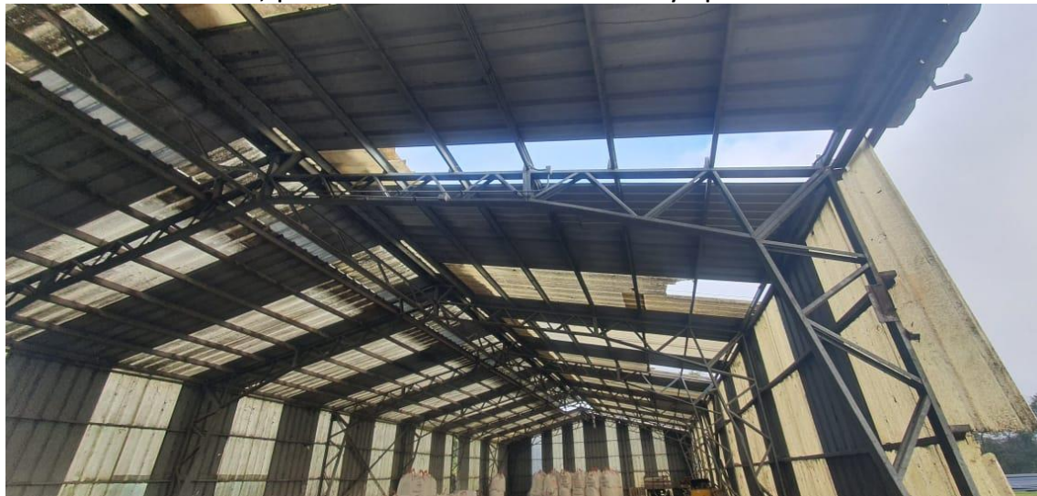
Foto 14 Galpón cerrado de secado de lodos, que evidencia daños estructurales laterales y superiores
