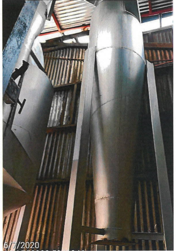
Ciclón – obra terminada
