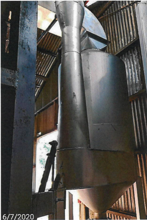
Depurador tipo Venturi – obra terminada
