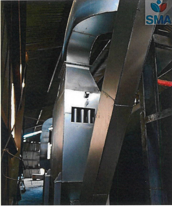
Calentador de gases – obra terminada
