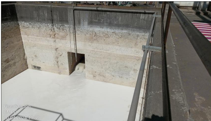
Fotografía 3. Interior de la cuba de recepción de RILes.
