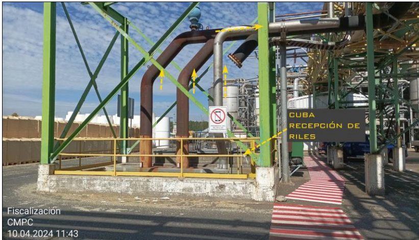
Fotografía 1. Vista general de la cuba de recepción de RILes. Se indican las salidas de RIL y la conducción que deriva los RILes desde la cuba a la planta de tratamiento de RILes.
