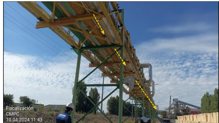
Fotografía 4. Sistema de conducción de RILes desde la cuba de recepción hacia la planta de tratamiento de RILes.
