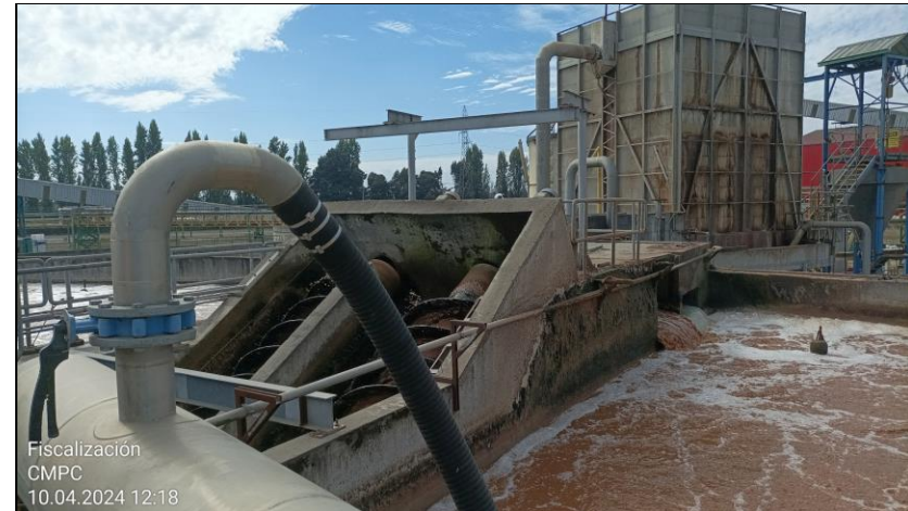
Fotografía 8. Vista del sector radial en el Clarificador Secundario.
