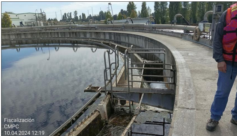
Fotografía 9. Vista del sector central del Clarificador Secundario.
