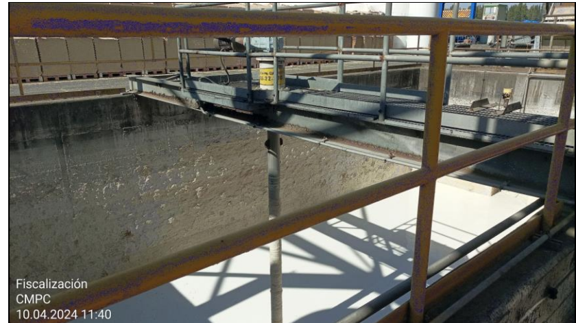
Fotografía 2. Interior de la cuba de recepción de RILes.
