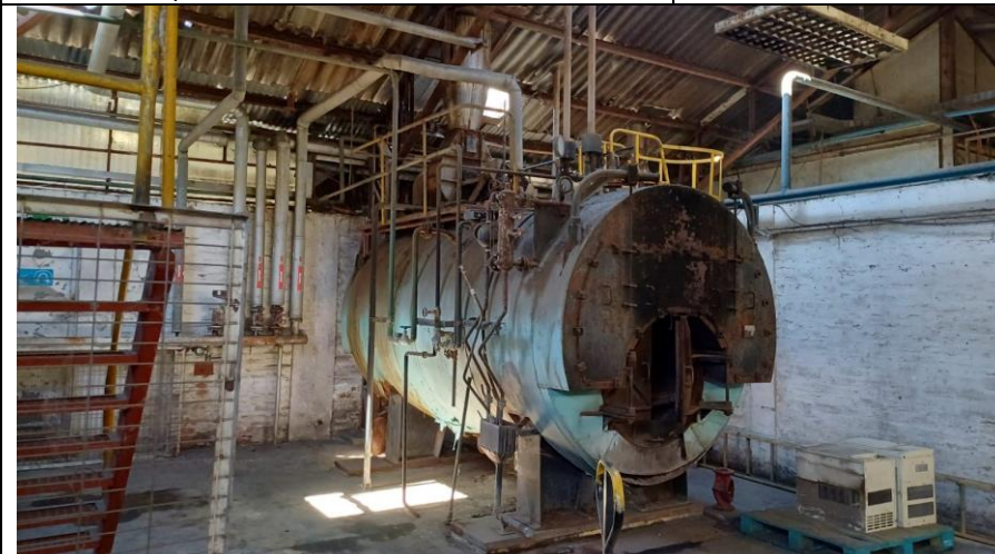
Fotografía 11. Caldera SSMAU-375-FF, deshabilitada, localizada en planta Lontué (fotografía enviada por el titular).
