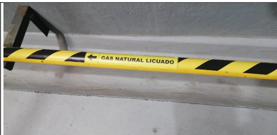
Fotografía 10. Tubería de gas licuado que alimenta las calderas.
