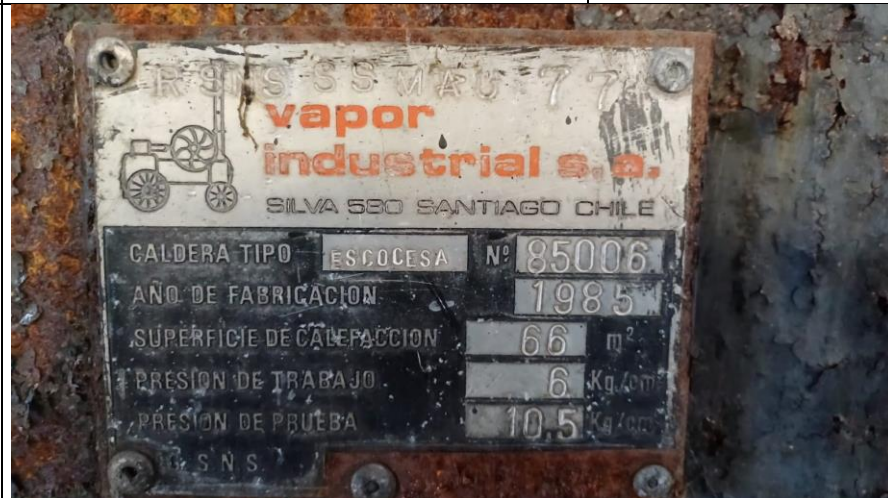
Fotografía 12. Placa de caldera SSMAU-375-FF, deshabilitada, localizada en planta Lontué (fotografía enviada por el titular).
