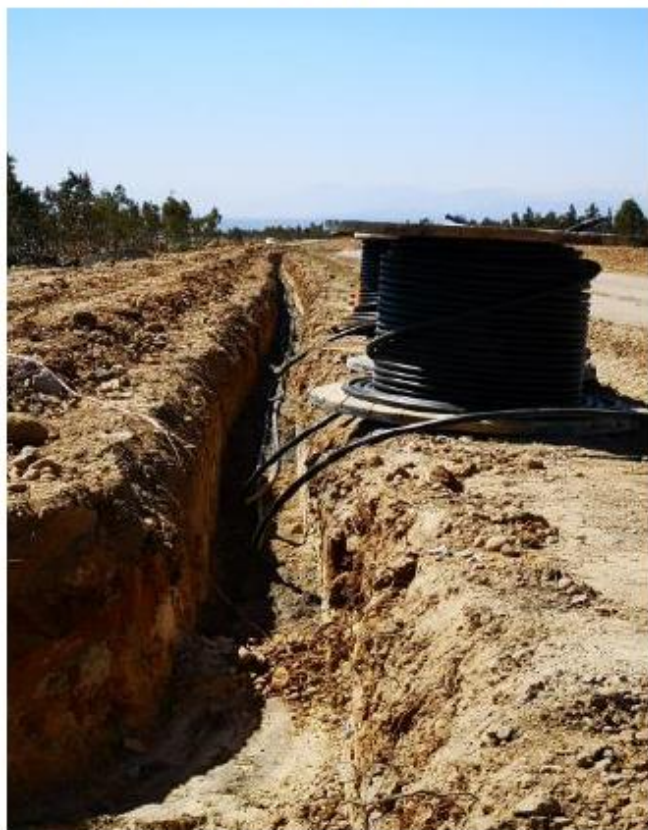
Fotografía 1. Excavación zanjas media tensión
