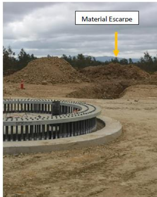
Fotografía 2. Material de escarpe al costado de la plataforma
