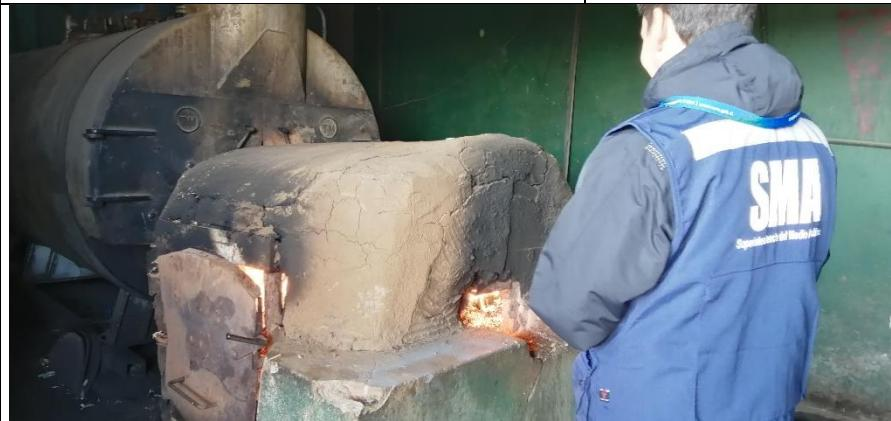
Fotografía 3. Caldera generadora de vapor SSMAU-89.
