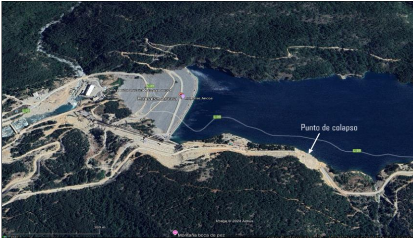
Fotografía 1. Imagen satelital donde se indica el punto de colapso de la Ruta L-39.
