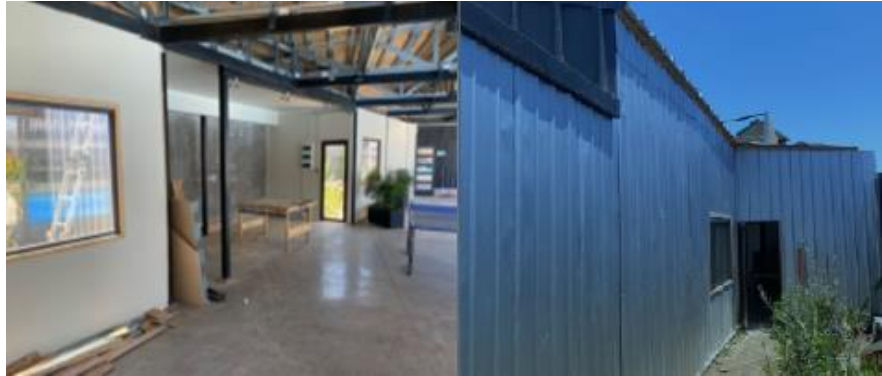
Fotografía N°5: Cierre sector terraza cafetería, revestimiento interior con volcánita y exterior con planchas de zic
