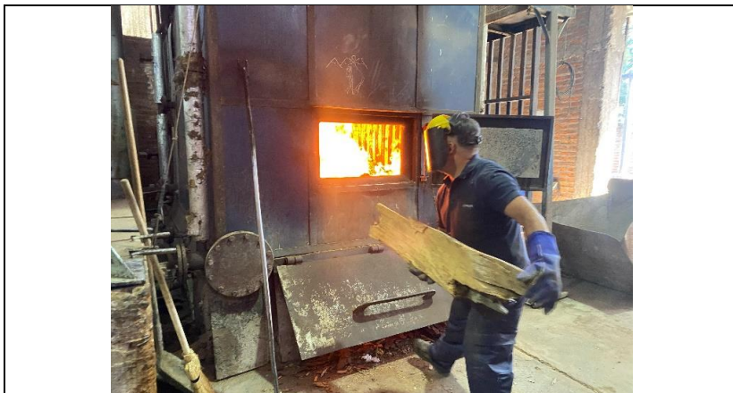
Fotografía 1. Caldera a leña SSMAU-116 que se encontraba operando al momento de la inspección de fecha 19-03-2025 en CURTIEMBRE RUFINO MELERO. Fuente: Informe DFZ-2025-2388-VII-PPDA.
