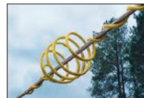
Figura 17: Cable de guardia marcado con un disuasor que aumenta su grosor por sobre y por debajo del mismo. Fuente: Modificado de 229
