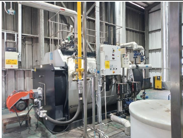
Fotografía 3. Nueva caldera a GLP en las dependencias de la UF.
