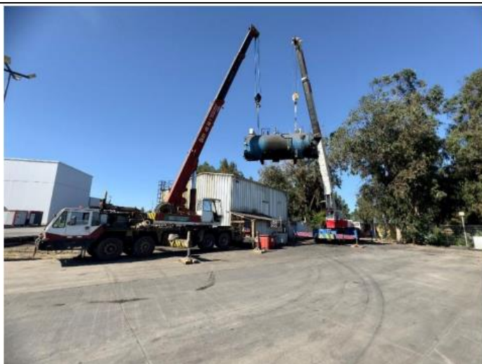
Fotografía 1. Desmontado de caldera a carbón bituminoso 2 de diciembre de 2023, (foto enviada por titular).
