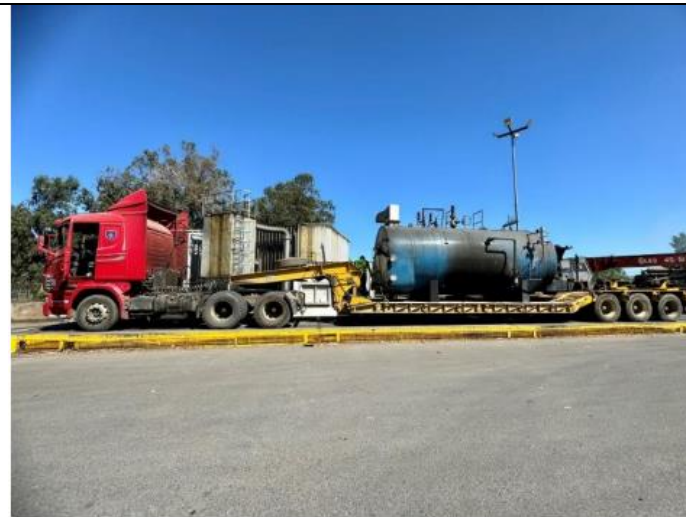
Fotografía 2. Desmontado de caldera a carbón bituminoso 2 de diciembre de 2023, (foto enviada por titular).
