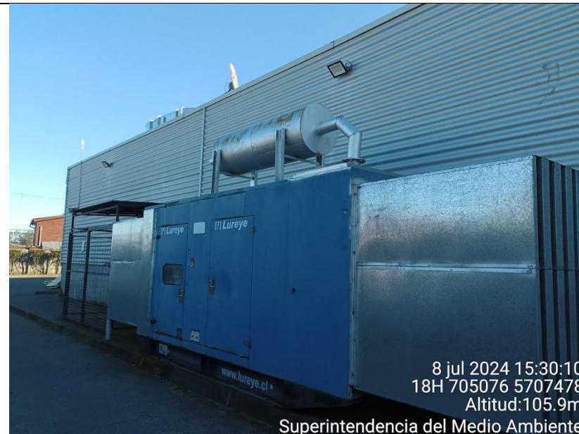
Fotografía 2. Imagen del grupo electrógeno, con sistema de silenciadores en techo y costados del equipo.
