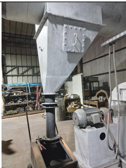
Fotografía N°5: sistema de abatimiento caldera SSMAU-327
