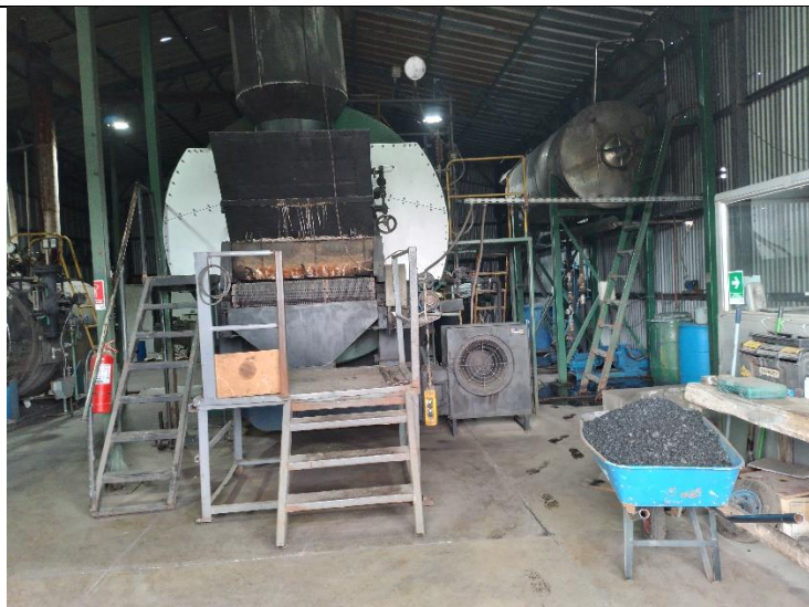
Fotografía N°3: caldera a carbón bituminoso SSMAU-327
