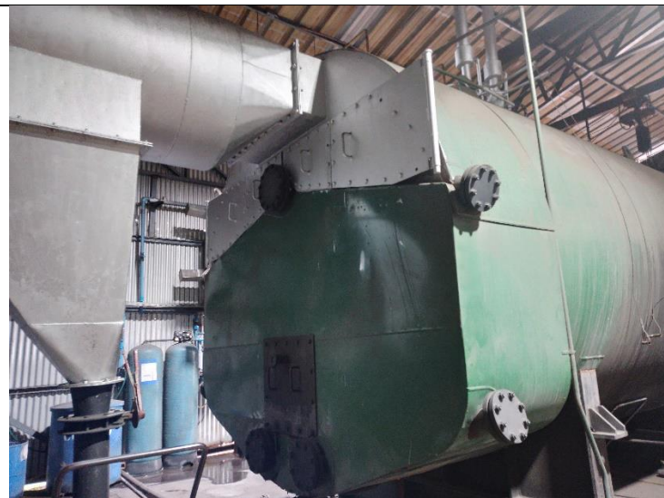
Fotografía N°4: caldera a carbón bituminoso SSMAU-327
