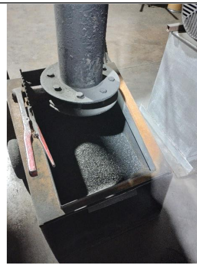
Fotografía N°6: sistema de abatimiento caldera SSMAU-327
