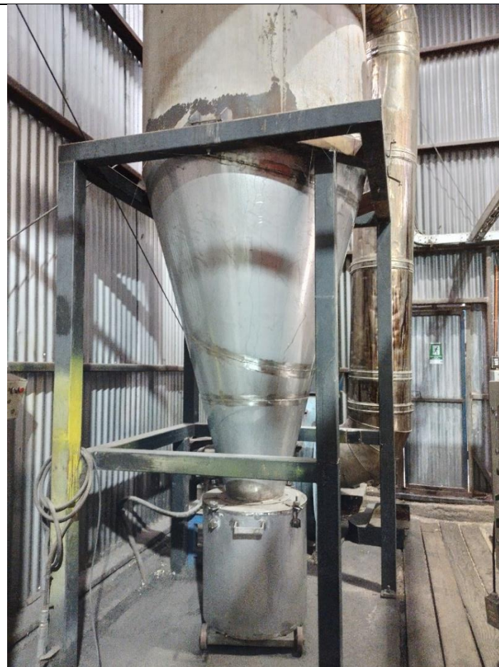
Fotografía 6. Sistema de abatimiento de material particulado caldera SSMAU-238.
