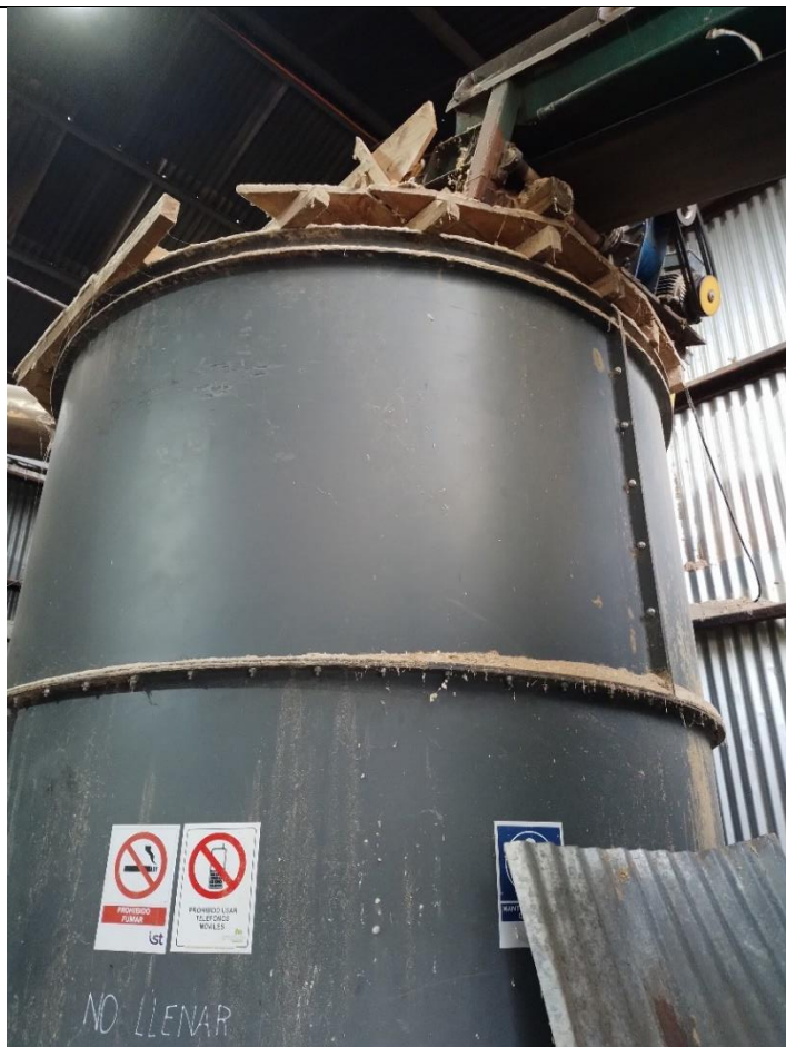
Fotografía 5. Sistema de alimentación automática caldera SSMAU-238.
