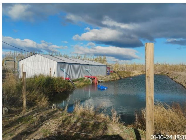
Fotografía N°3. Sala de bombas y excavación de acumulación de aguas de afloramiento subsuperficial.
