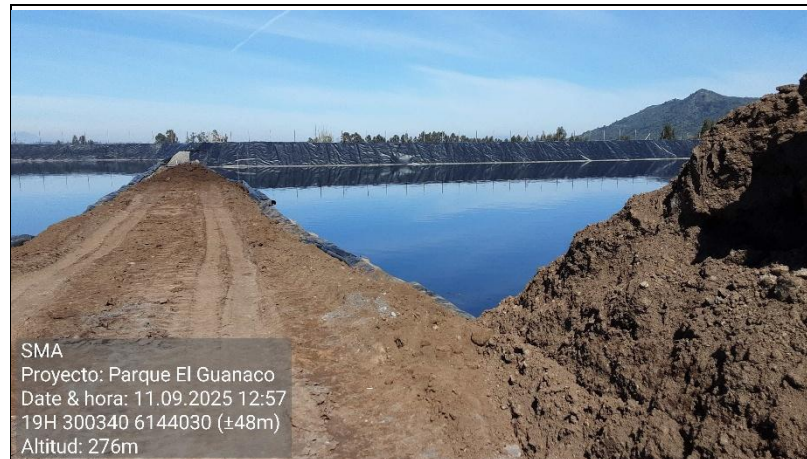
Fotografía 2. A la izquierda, Piscina N.º 7 y, a la derecha, Piscina N.º 6. Ambas unidades se utilizan como contención de lixiviados.
