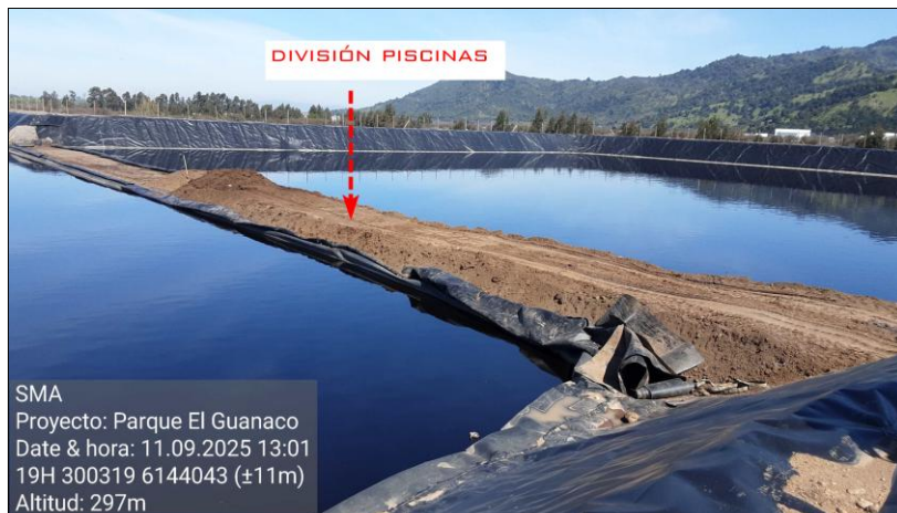
Fotografía 5. Fotografía en que se indica la separación de las Piscinas N.º 6 y N.º 7 que el titular pretende eliminar para contar con una sola unidad.
