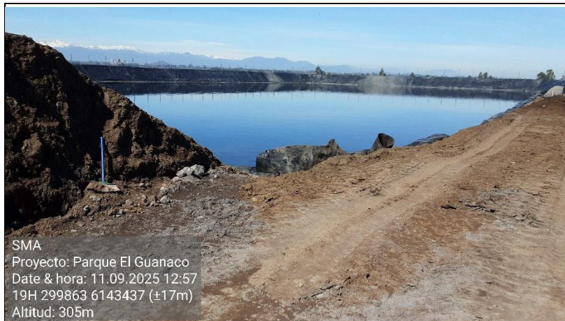
Fotografía 1. Fotografía de Piscina N.º 7 donde eventualmente ocurre la filtración de lixiviado detectada por el titular en sector aledaño a dicha unidad.
