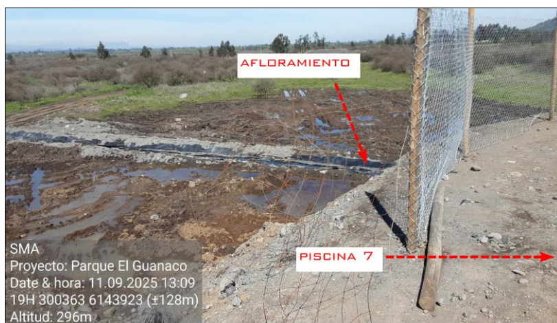
Fotografía 7. Vista general del sector donde se detectó el afloramiento de lixiviado.
