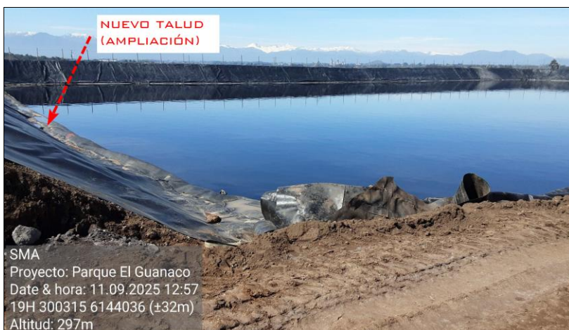
Fotografía 3. Perfil del nuevo talud asociado a la ampliación de la Piscina N.º 7.
