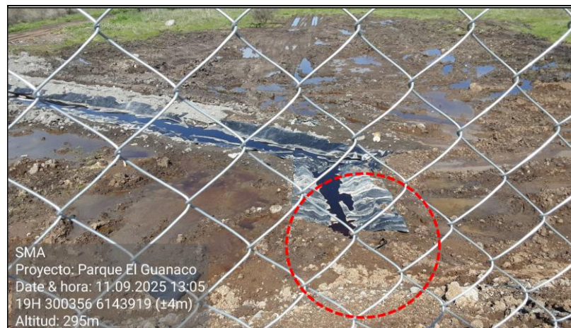
Fotografía 6. Vista general del sector donde se detectó el afloramiento de lixiviado.
