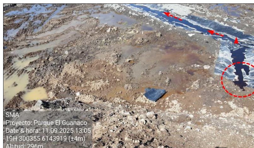
Fotografía 8. Vista en primer plano del sector donde ocurre el afloramiento de lixiviado y se puede apreciar la canaleta con geomembrana implementada por el titular para el retiro diario de lixiviados.
