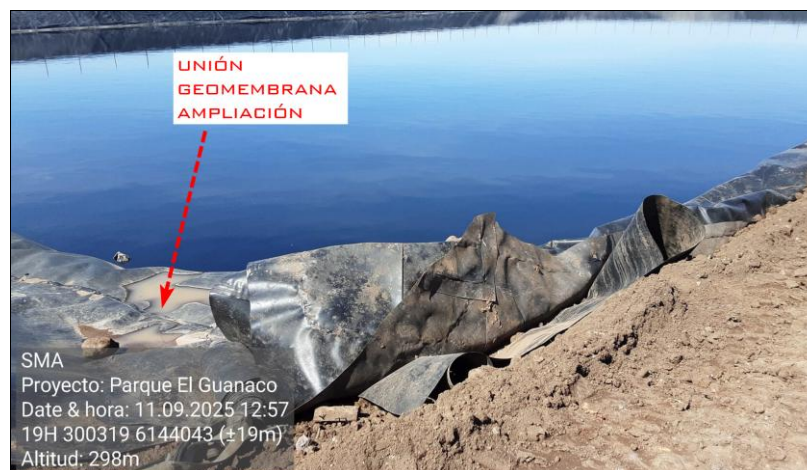
Fotografía 4. Se indica la unión de la membrana nueva con la antigua membrana de la Piscina N.º 7, donde el titular sospecha se generó la fuga de lixiviado.
