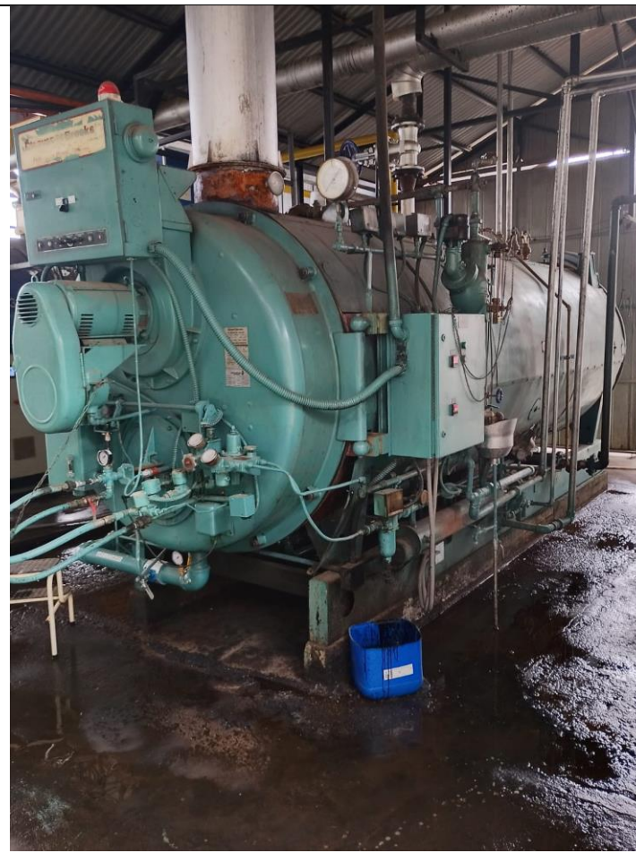
Fotografía 4. Caldera SSMAU-261 que funcionaba anteriormente a petróleo.
