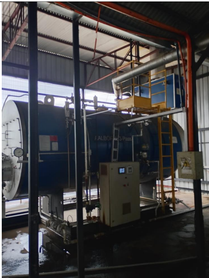
Fotografía 3. Caldera a gas SSMAU-356-V.
