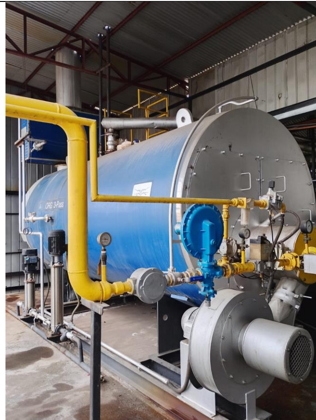
Fotografía 2. Caldera a gas SSMAU-356-V.
