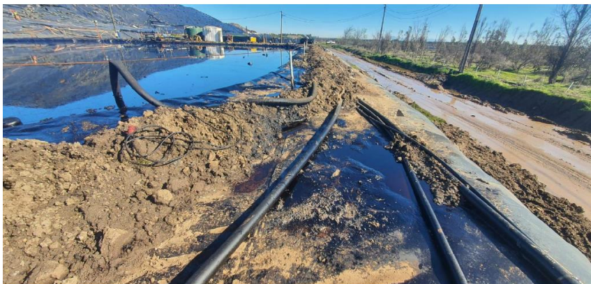
Foto 15 CITA Incidente Celda V2A Lado Sur Foco de filtración activo N1 y en control de confinamiento.
