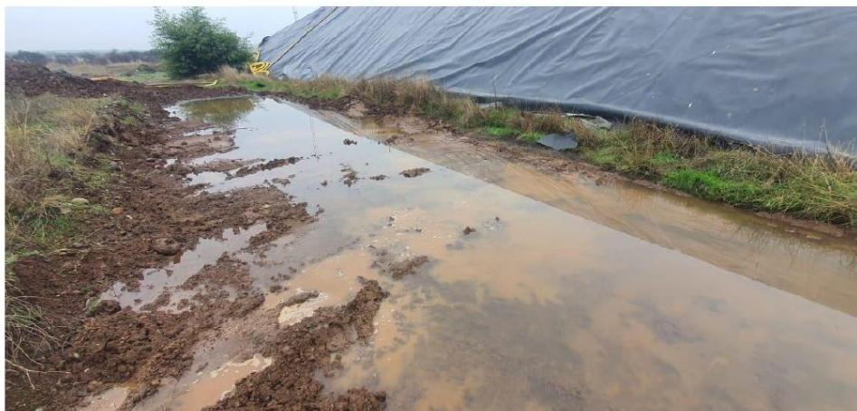
Foto 4 ZONA DE INCIDENTE REPORTADO DONDE SE EVIDENCIA ESCARPE Y AUSENCIA DE LIXIVIADOS CITA
