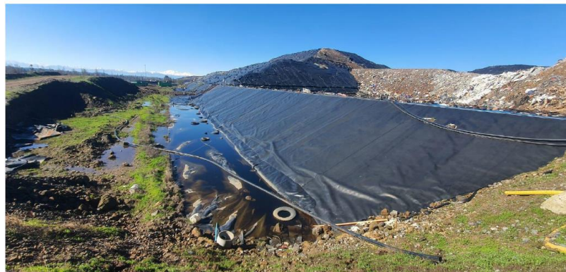
Foto 15 CITA Incidente Celda V2A Lado Sur Foco de filtración activo N1 y en control de confinamiento.
