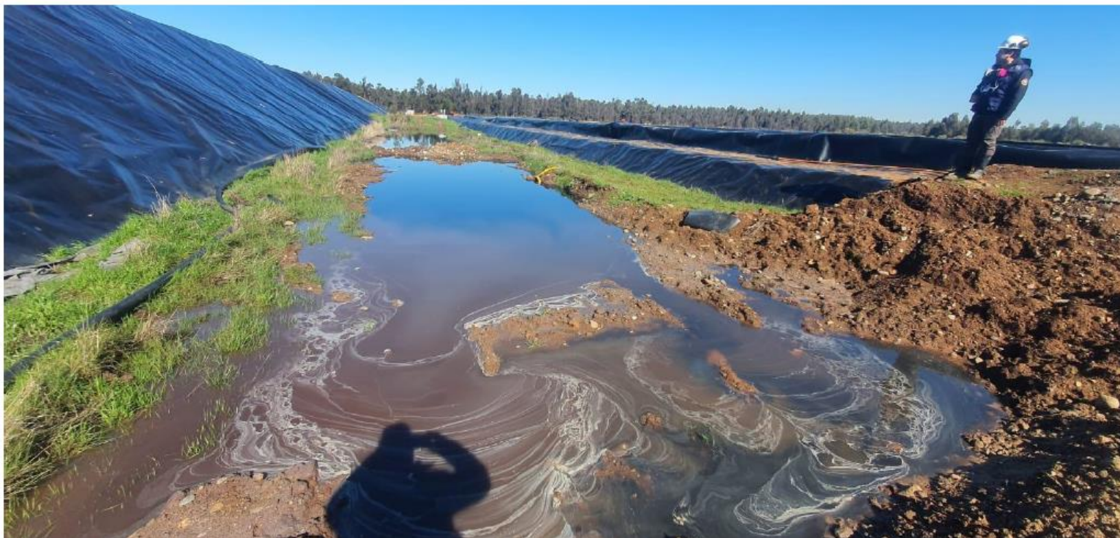
Foto 20 CITA Celda Incidente pulmón Lado Oriente presencia de lixiviados superficiales, sin evidencia de aportes de caudales de lixiviados
