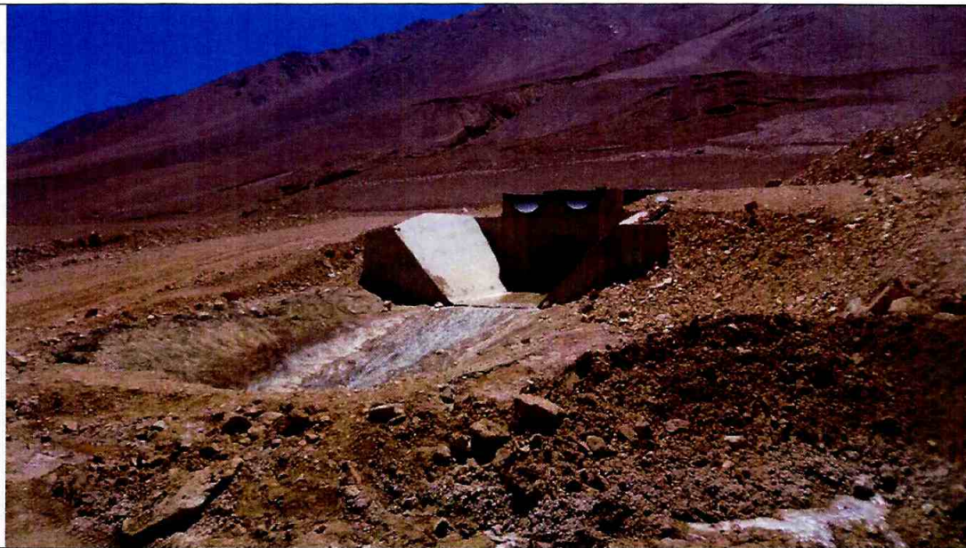
Foto 5: Detalle obra de descarga del Sedimentador Norte (16-02-2014)
