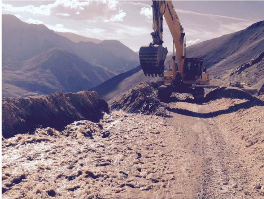
Figura 4: Excavadora direccionando flujo de agua a quebrada antigua, hacia línea de gaviones de niveles Inferiores
