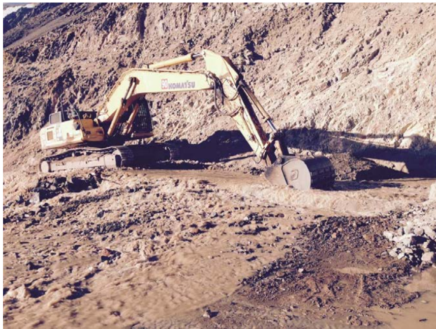
Figura 5: Excavadora trabajando en limpieza de OA "0" en zona de parilla protectora para despeje y recuperación de flujo hacia OA1
