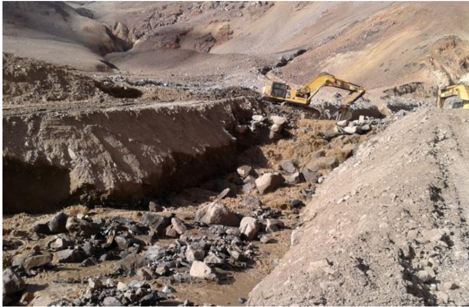
Figura 4 – Retiro de rocas/sedimentos en muro de gaviones superior quebrada La Negra.
