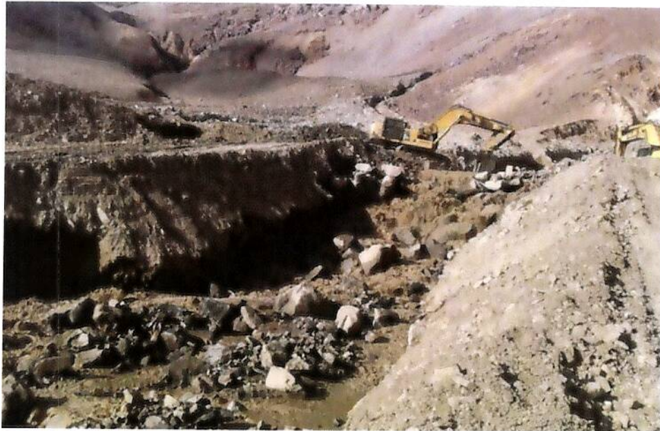
Figura 4 – Retiro de rocas/sedimentos en muro de gaviones superior quebrada La Negra.
