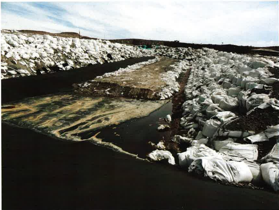
✓ Imagen N° 8. Drenaje de lixiviados y geomembranas.
