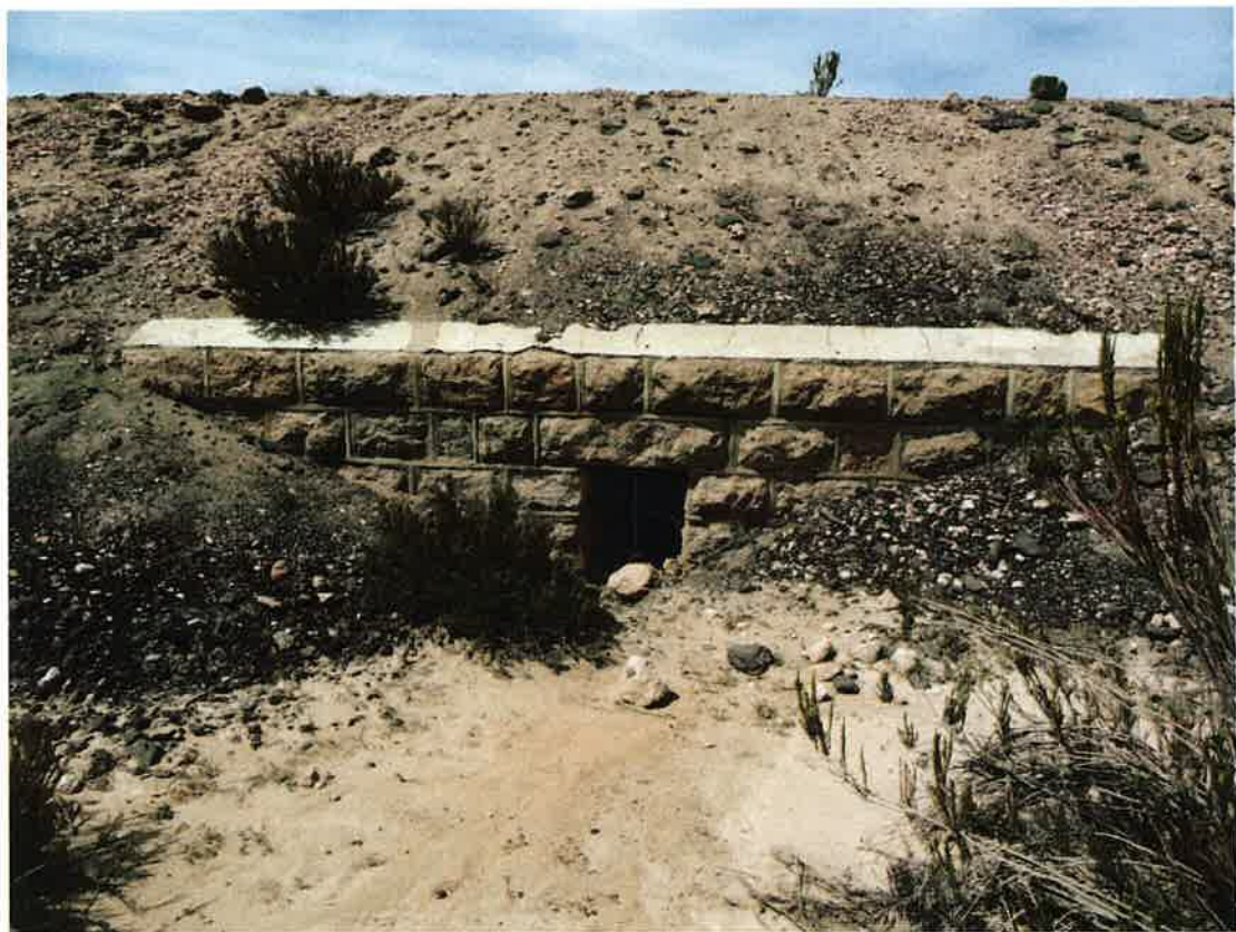
Imagen N° 2. Obra de paso, quebrada oeste al relleno.
