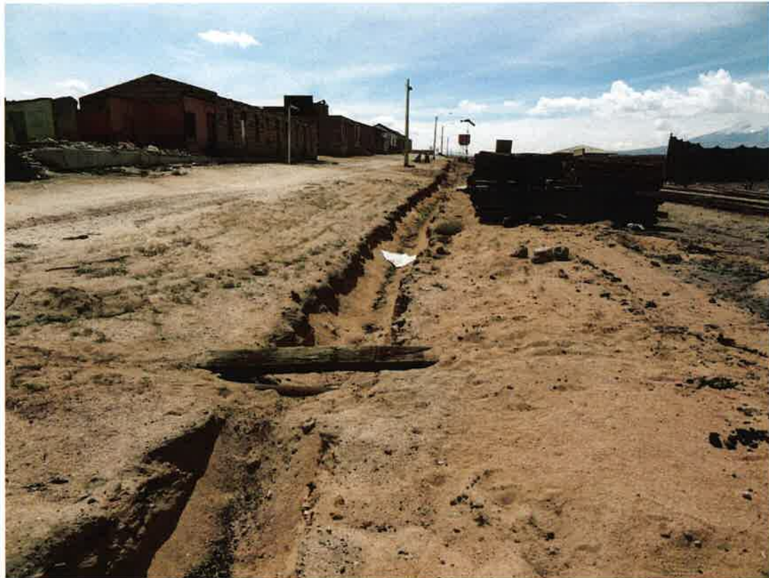
Imagen N° 4. Zanja intersección de aguas lluvias, la cual se encuentra obstaculizada por un paso conformado de tierra, el cual no permitiría el libre escurrimiento de las aguas.
