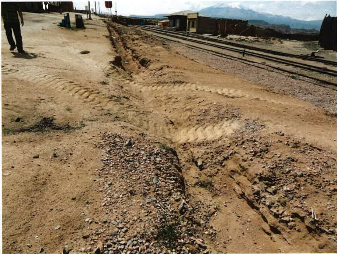
Imagen Nº 5. Zanja intersección de aguas lluvias intervenida por el atravesio de maquinaria pesada, conformado de tierra, el cual no permitiría el libre escurrimiento de las aguas lluvias.
