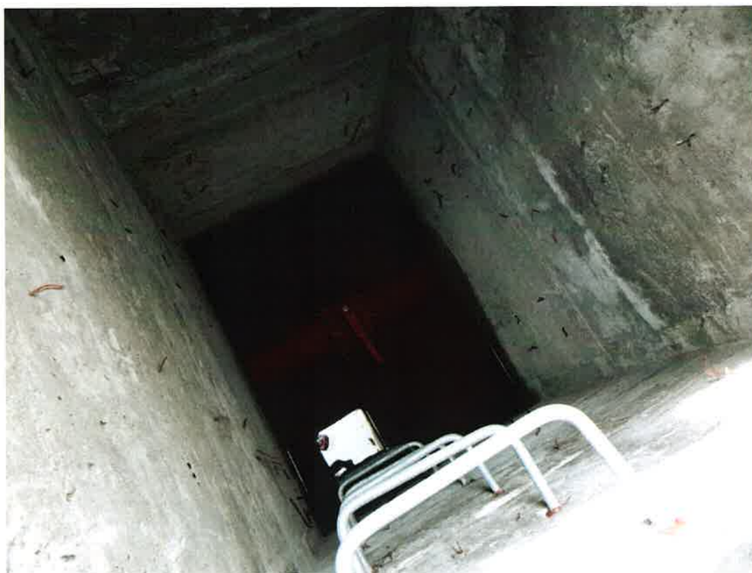
Imagen N° 10. Cámara de lixiviados con presencia de líquidos en su interior.
