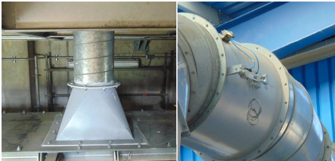
Imag. 2 (a) Campana Succión Correa Camiones, (b) Damper neumático
