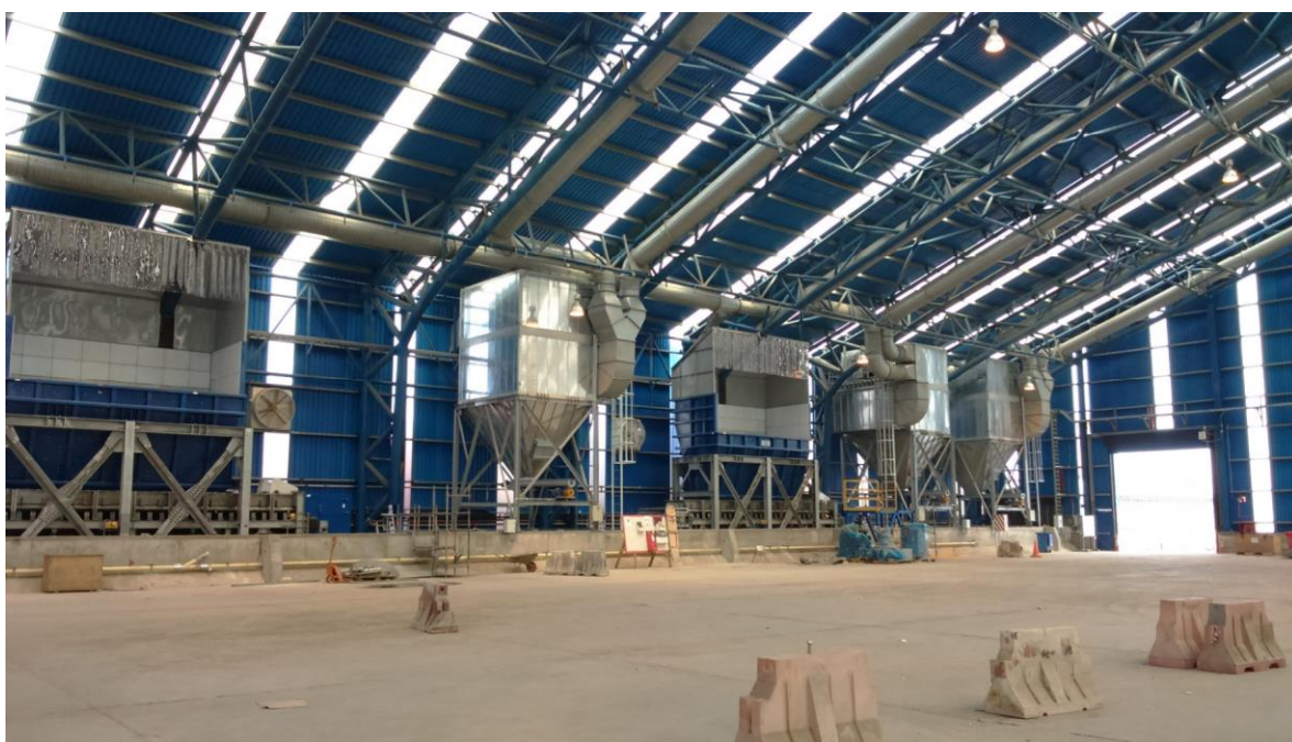
Imag. 1. Equipos Colectores de Polvo, Sistema de Ventilación y Control de Polvo Edificio Acopio/Stock Pile
