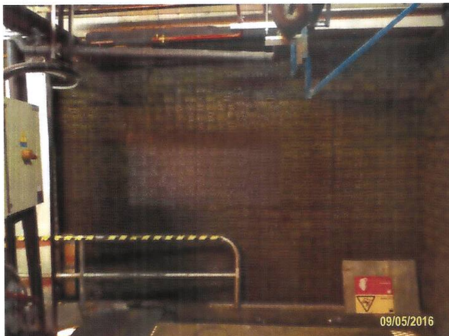
Imagen 9. Recubrimiento con material fonoabsorbente sala de compresores (sala de máquinas).
