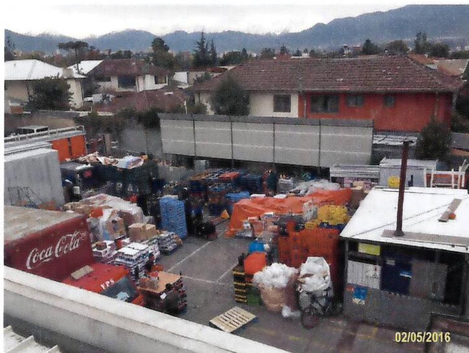
Imagen 7. Patio de descargas con pantalla acústica perimetral.
