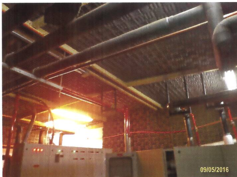
Imagen 10. Recubrimiento con material fonoabsorbente sala de compresores (sala de máquinas).
