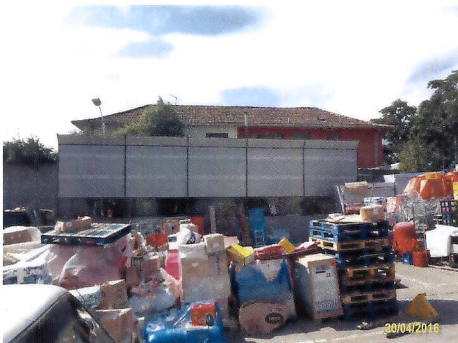
Imagen 8. Barrera acústica perimetral en el patio de descargas.
