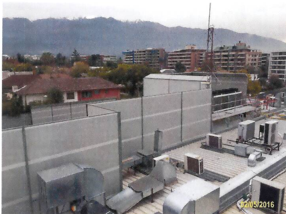
Imagen 4. Barrera acústica perimetral en la cubierta + Barrera parrilla de condensadores.
