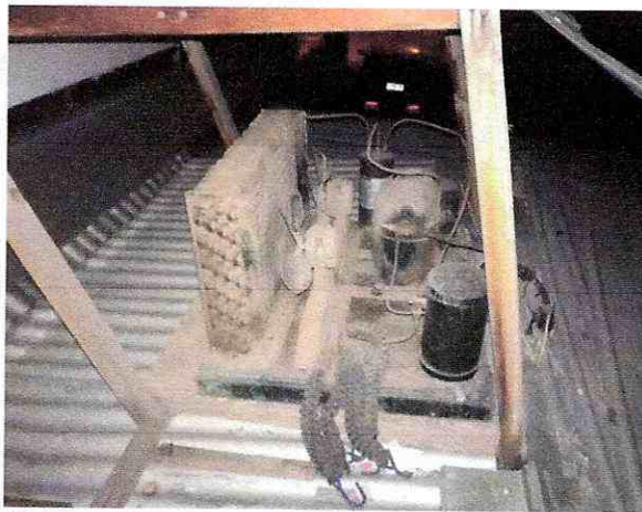
Figura 7: Unidad condensadora de vitrinas ubicada en la techumbre del Local.
