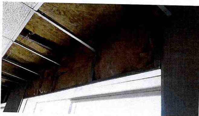
1. Construcción de sobre tabique en lana de vidrio de 40 mm y placas de yeso cartón de 15 mm.
