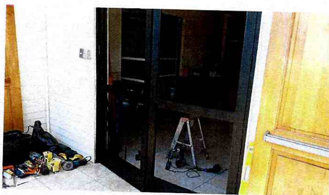
3. Instalación de mampara termopanel.
