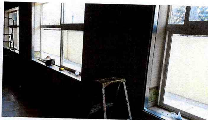
2. Instalación de ventanas Termopanel 2,40 x 1,10 en costado norte.
