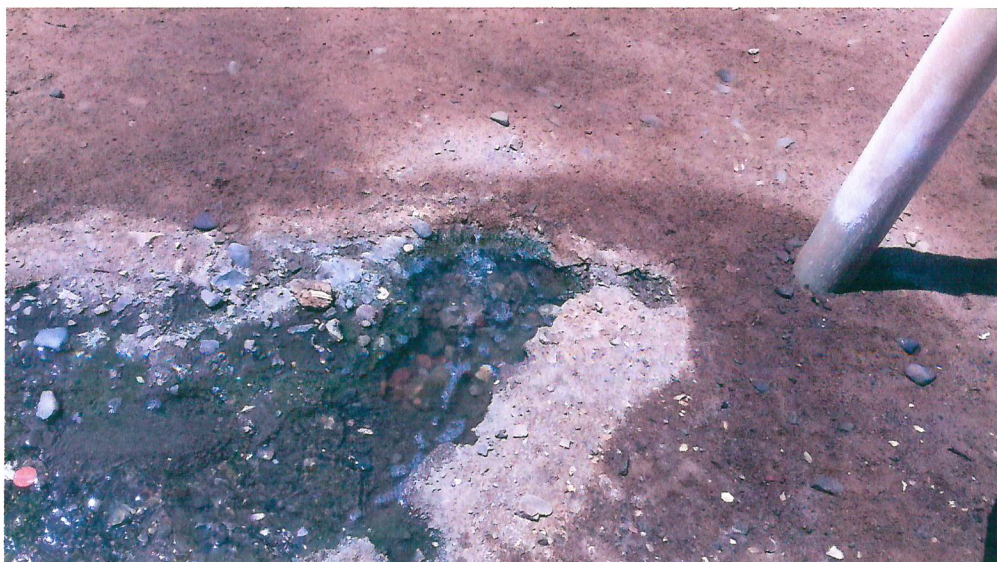
Afloramiento de las aguas provocando colapso del sistema.
