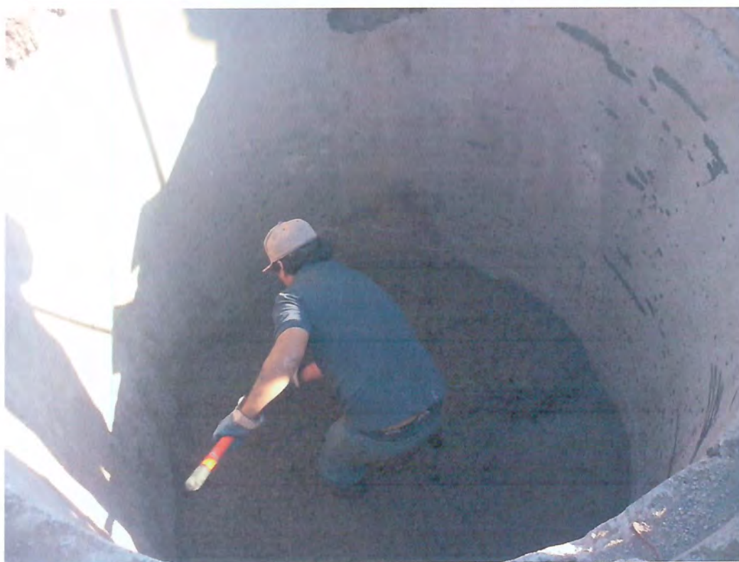
Imagen 1 y 2: Construcción de fondos de estanques de hormigón
