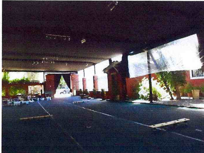
Figura 6 – Fachada 2 de la carpa vista desde el interior.
