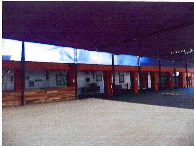
Figura 8 – Fachada 4 de la carpa vista desde el interior.
