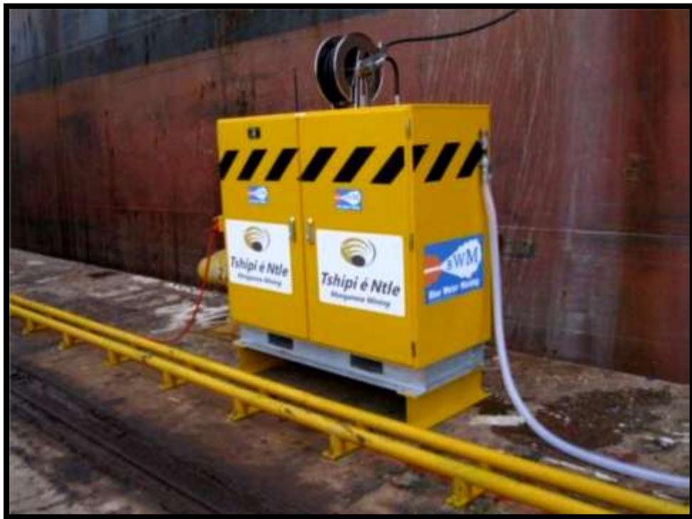
Figura 4. Bomba instalada en muelle
