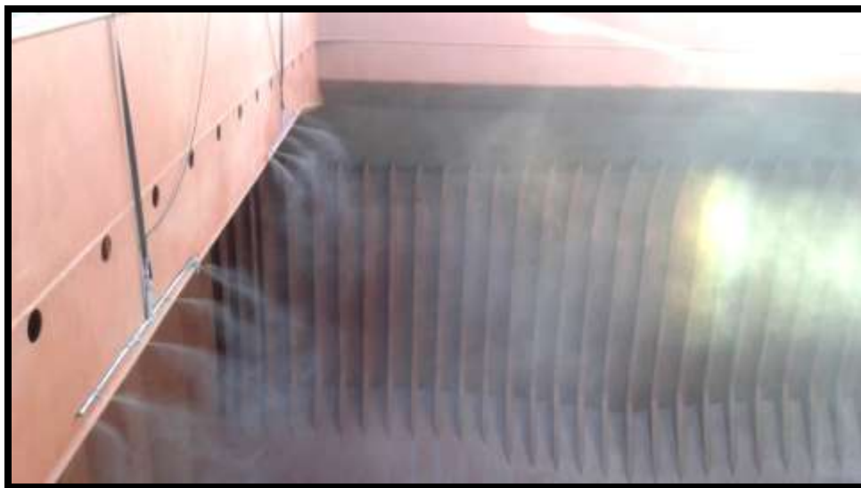
Figura 2. Equipos nebulizadores instalados
