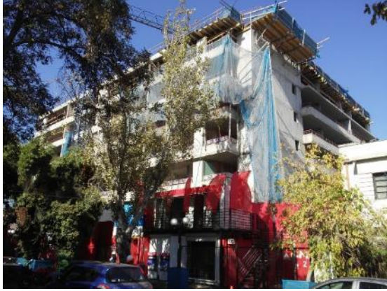
Fachadas oriente y norte, acceso obra
