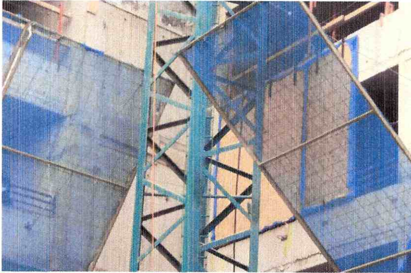
Pantalla acústica en ventanas.
