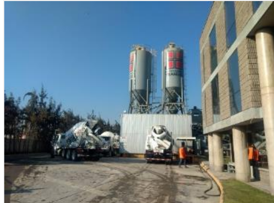
Planta de hormigón
