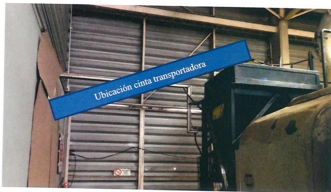
Fotografía 1 y 2. Se evidencia con estas fotografías la ausencia de la cinta transportadora que elevaba el suministro de biomasa proveniente de la bodega de Aserrín.
