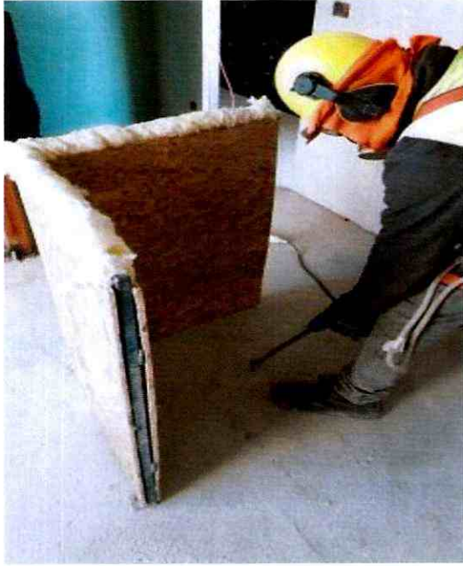
-Barrera de material absorbente acústico en el cierre perimetral.
