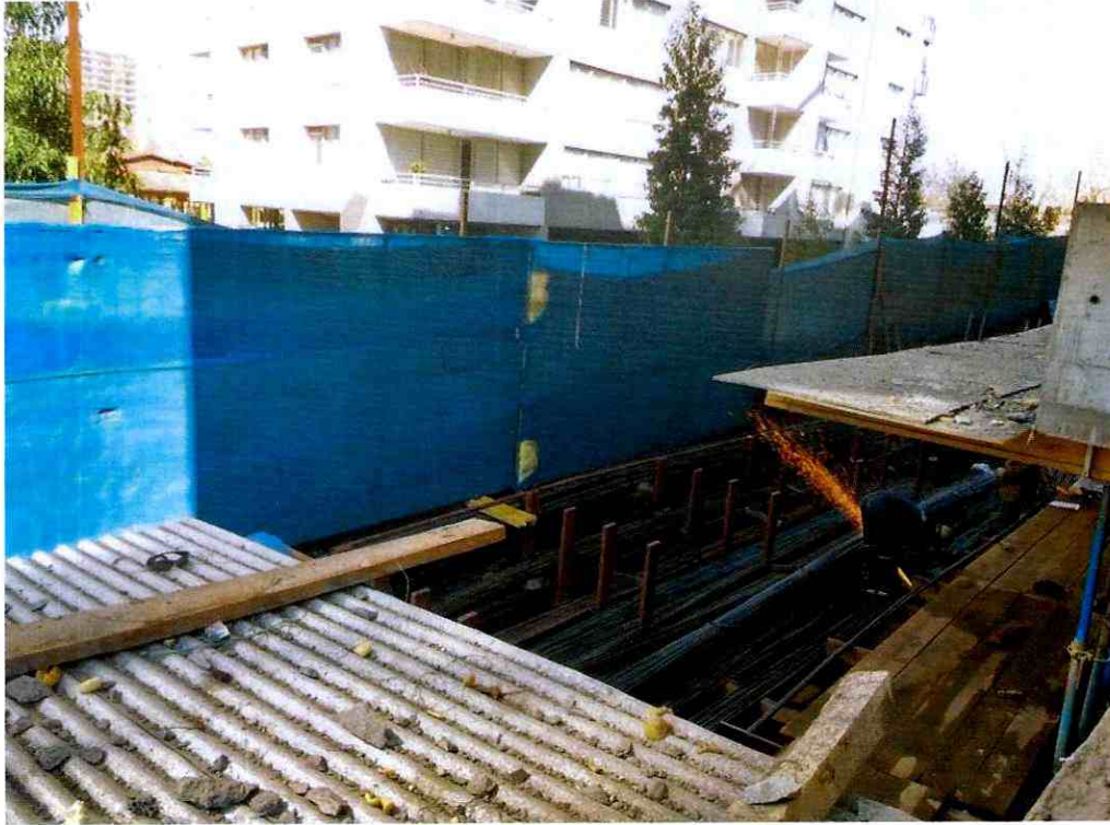
-Barrera de material absorbente acústico en el cierre perimetral.
