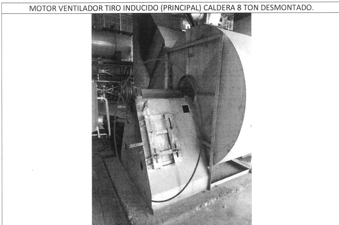
Fotografía 1. Desmontaje de Motor ventilador de tiro forzado
