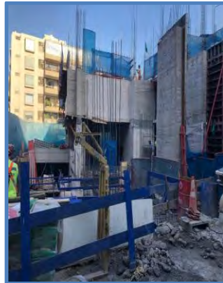
Figura 3. Rotomartillos Preparando Muros y Losas.
