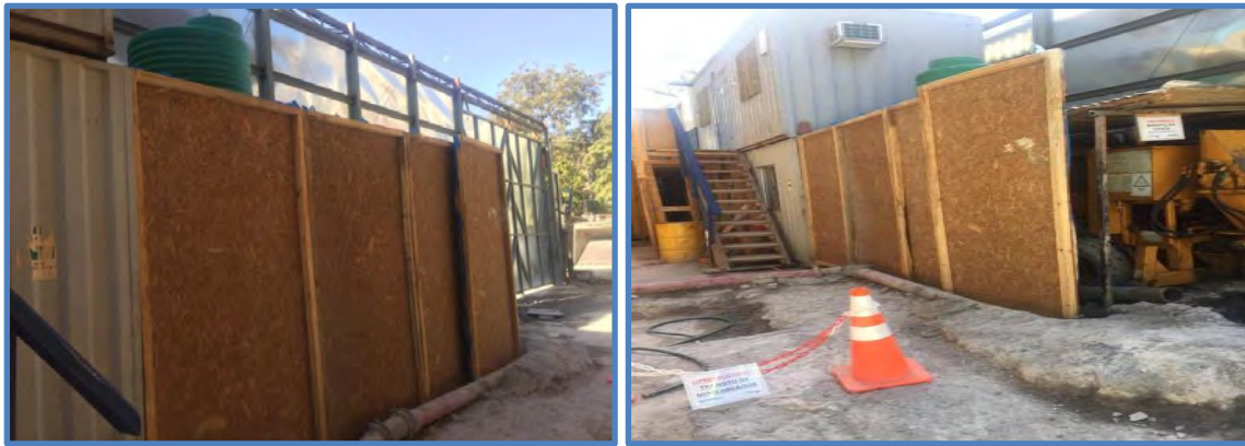
Figura 8. Apantallamiento Parcial Bomba de Hormigón.
