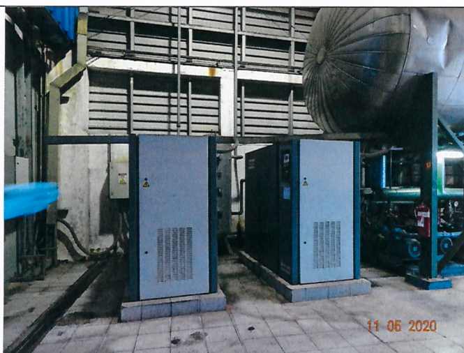
Imagen 1: Compresores conectados en cadena
