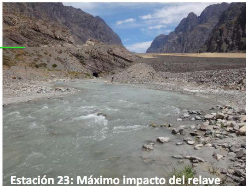
Figura 7. Vista general de la estación 23, correspondiente a la zona de impacto directo del derrame de relave (Enero 24, 2019).
