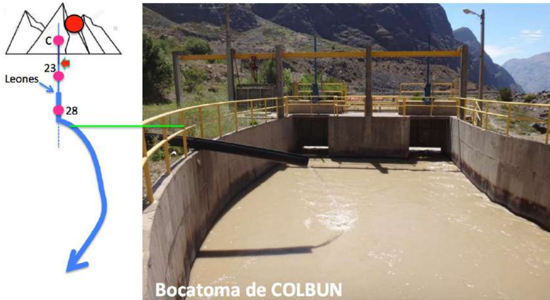
Figura 21. Bocatoma del Colbún S.A. que deriva el 100% de caudal del río Blanco hacia la central Blanco y juego devolver las aguas el río Aconcagua (Enero 24, 2019).
