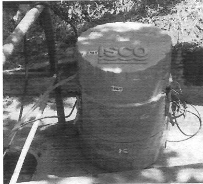
Fotografía 1: Instalación Equipo Automatico
