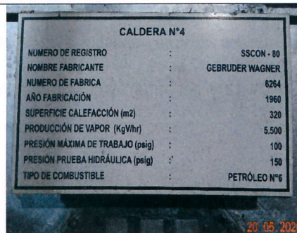
Fotografía 9: Placa de identificación caldera 4.
