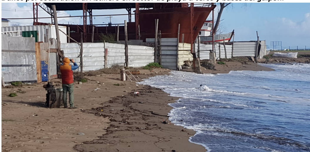
Daños por socavación al Astillero en sector de playa a cerco y bases del galpón.
