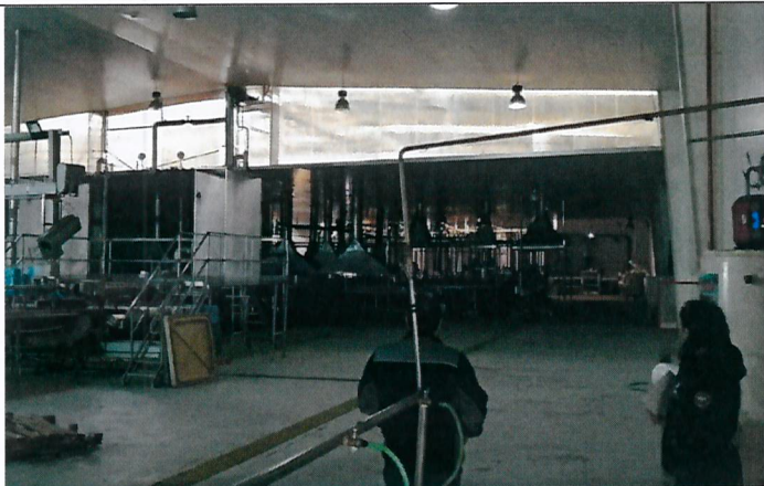
Fotografía 1. Trabajos de mantención - Área Productos Crudos
