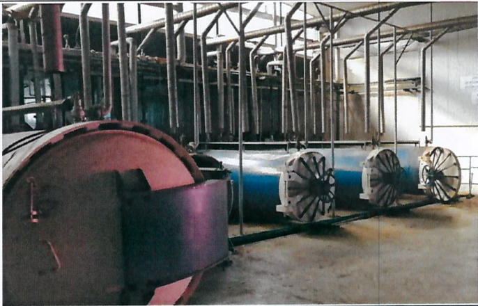
Fotografía 2. Trabajos de mantención - Área Productos Crudos
