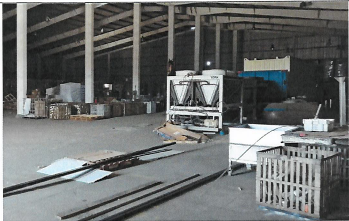
Fotografía 3. Bodegas de almacenamiento de la planta.
