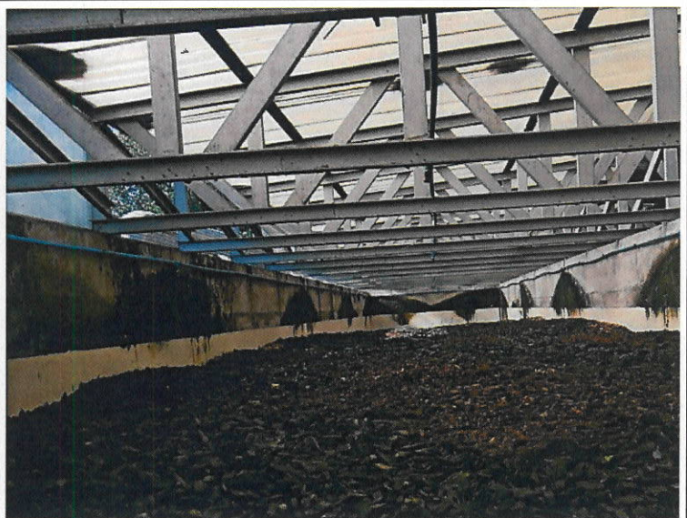
Foto 7 Biofiltro con sustrato de chip de epino
