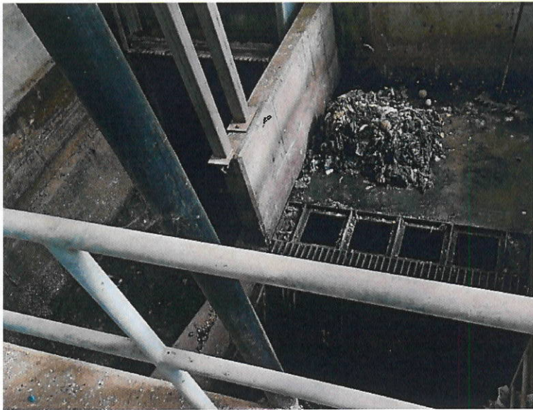
Foto 4 Retiro de residuos área de rejas de forma manual sector PEAS
