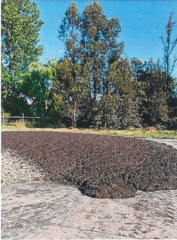
Foto 19 Cancha abierta de acopio de lodos
