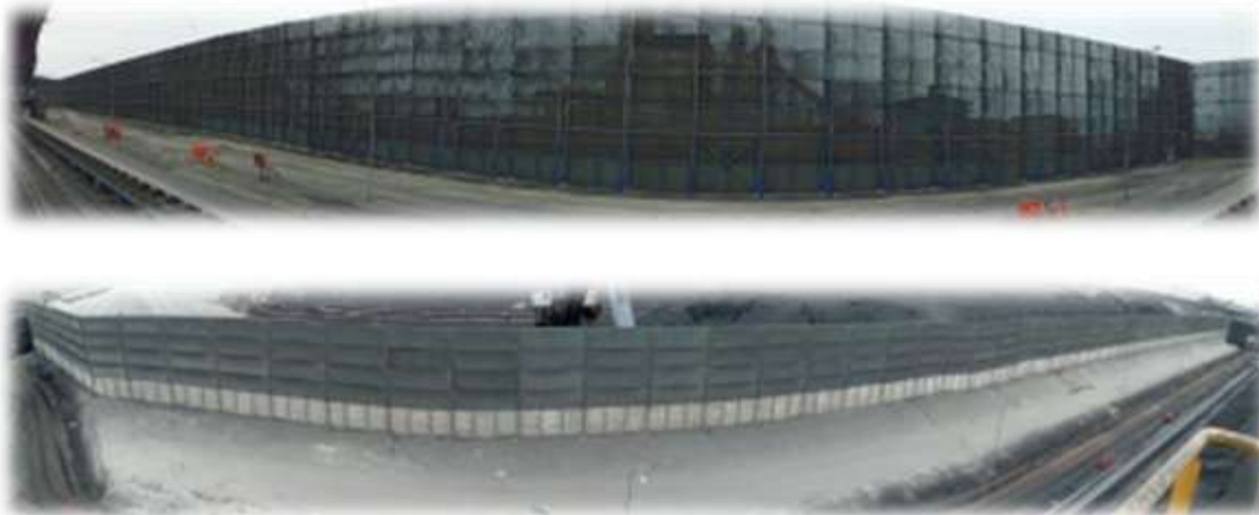
Foto 18: Pantallas Ambientales alrededor de cancha de carbón
