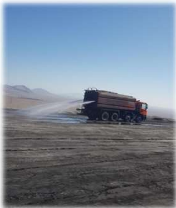
Foto 24: Humectación residuos combustión
