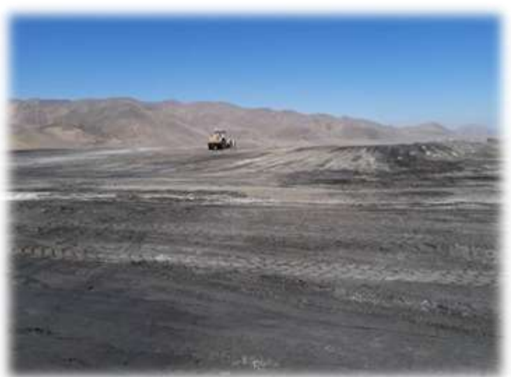
Foto 25: Compactación residuos de combustión
