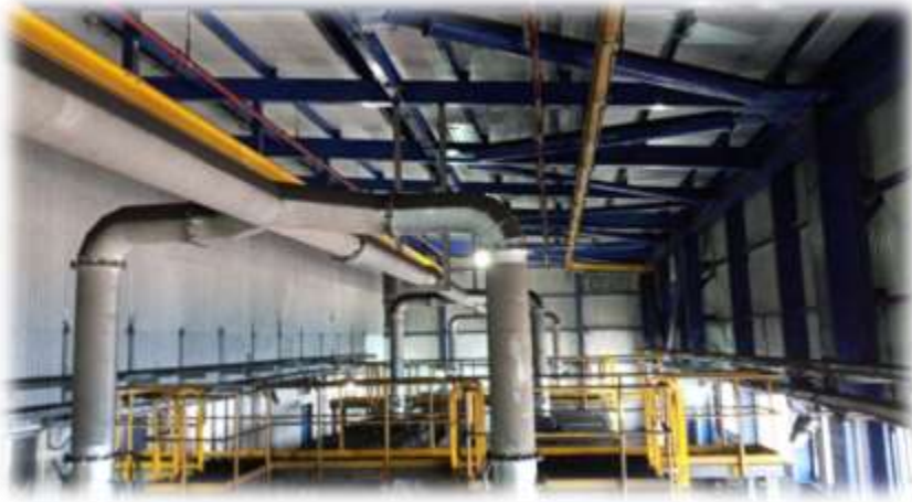
Foto 17: Galería cerrada Tripper
