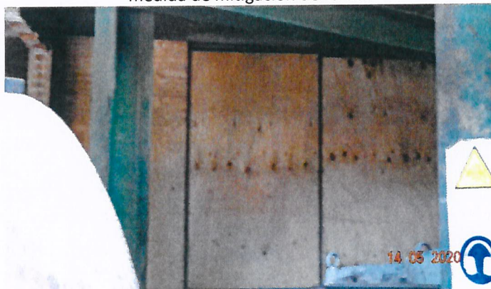
Fotografía 5. Paneles instalados al interior del astillador como medida de mitigación de ruido.
