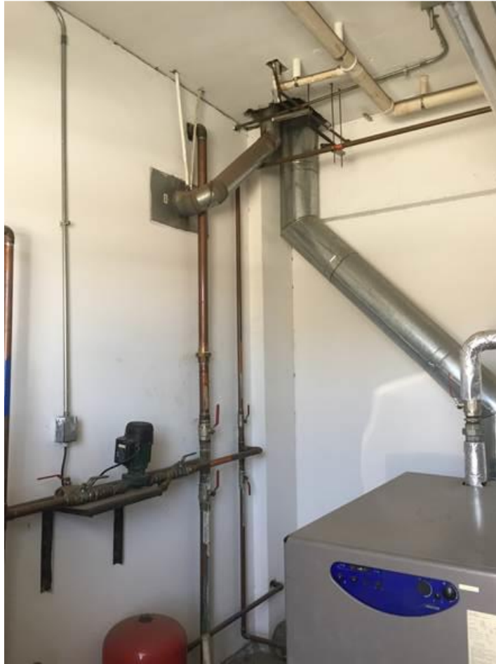
Figura 5. Sistema de evacuación de emisiones de caldera CESFAM Villa Magisterio.
